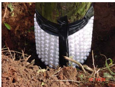
a - Poste com a bandagem fixada.
